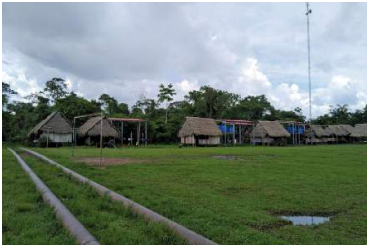
FIGURA 8.33. Ductos de petróleo atraviesan una comunidad del Patoyacu
