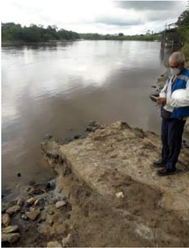
FIGURA 8.17. Sitio desde donde se descargaban libremente las aguas de producción al río Corrientes desde la Batería 1. Esta práctica se detuvo en el 2008
