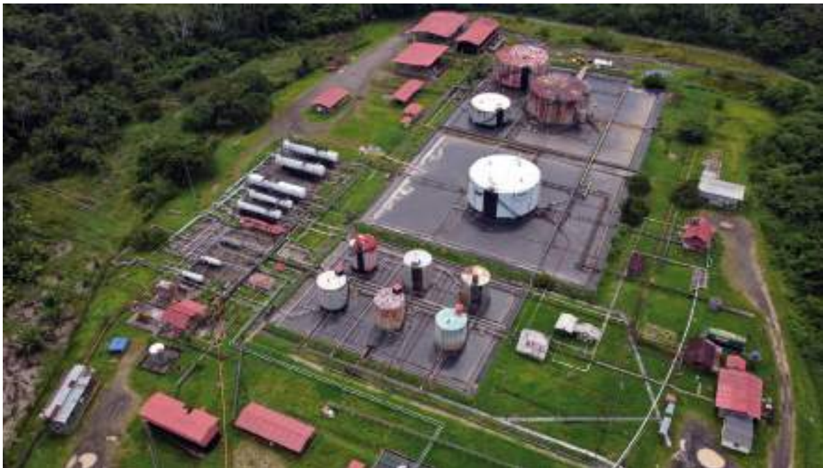
FIGURA 8.42. Vista aérea de la Batería 2. Yacimiento Corrientes
