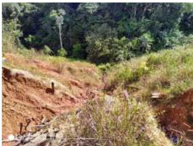
FIGURA 8.27. Aspecto de la erosión ocasionada por la escorrentía en la plataforma del pozo 1103. Yacimiento Pavayacu
