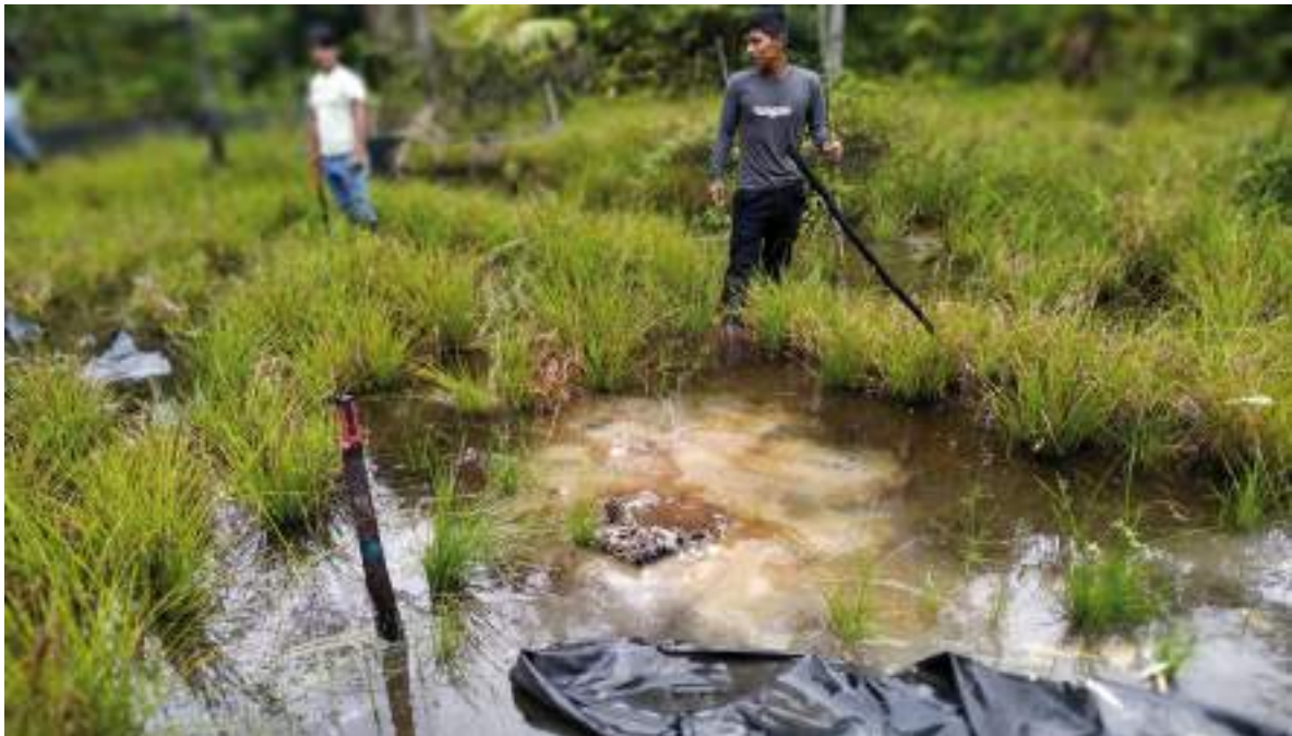
FIGURA 8.70. Aspecto del estado del sitio luego de la intervención por la fuga del oleoducto Trompetero-Saramuro en el Km 53.1. La Petrolera
