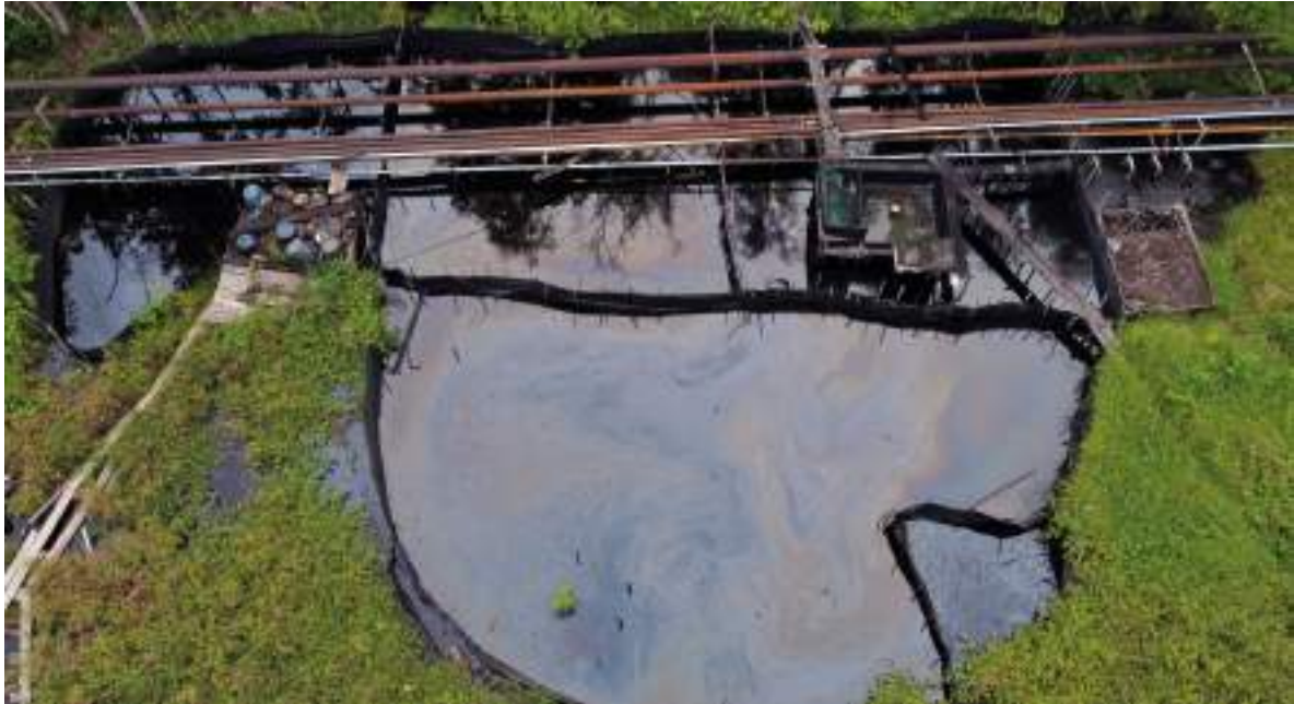
FIGURA 8.63. Imagen aérea del proceso de contingencia/remediación del impacto por la fuga de petróleo desde una tubería de producción. Batería 1. Yacimiento Corrientes
