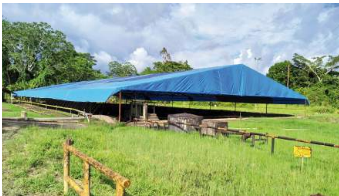
FIGURA 8.57. Antiguo Separador API de la Batería 2. Yacimiento Corrientes
