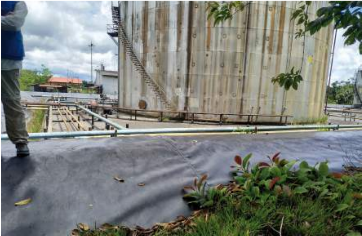
FIGURA 8.48. Impermeabilización de la fosa de tanques de petróleo en la Batería 3. Yacimiento Yanayacu
