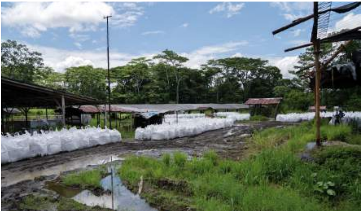
FIGURA 8.64. Big bags con suelo contaminado con petróleo producido por la remediación. Batería 1. Yacimiento Corrientes
