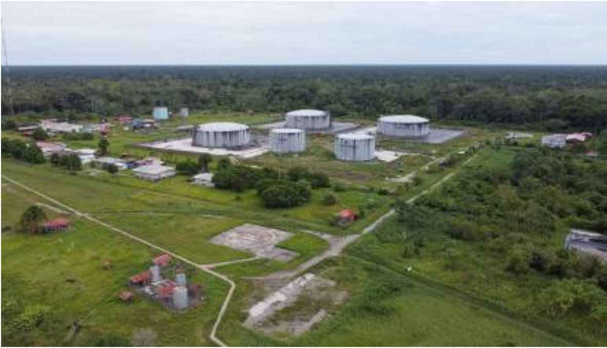
FIGURA 8.36. Vista aérea de la Estación N° 1. Saramuro
